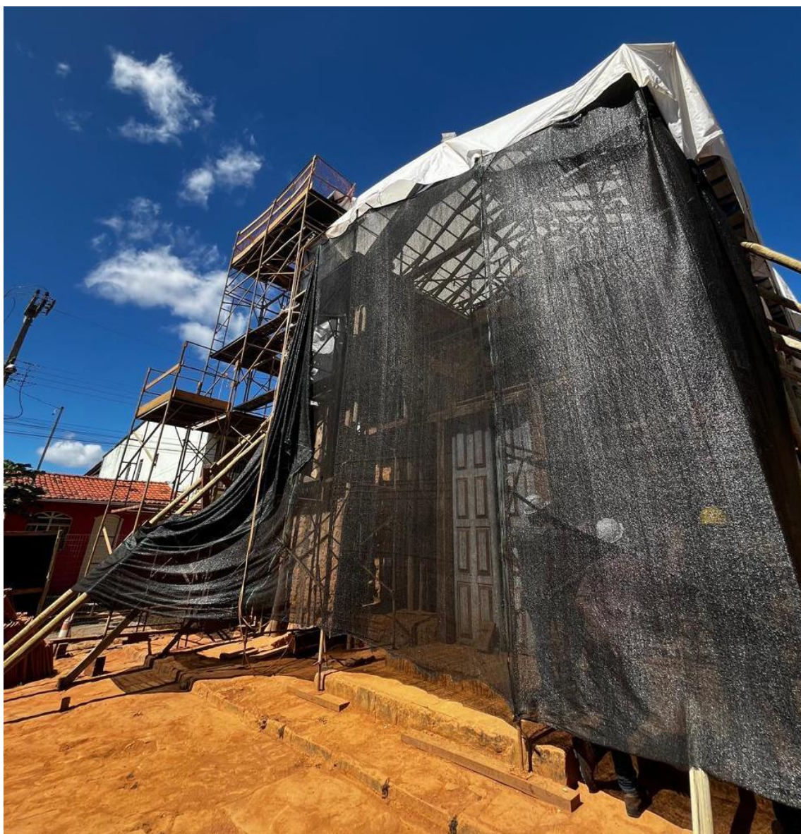
Intervenções em andamento na torre Autoria: Francielle Ferreira Data: 06/08/2024
