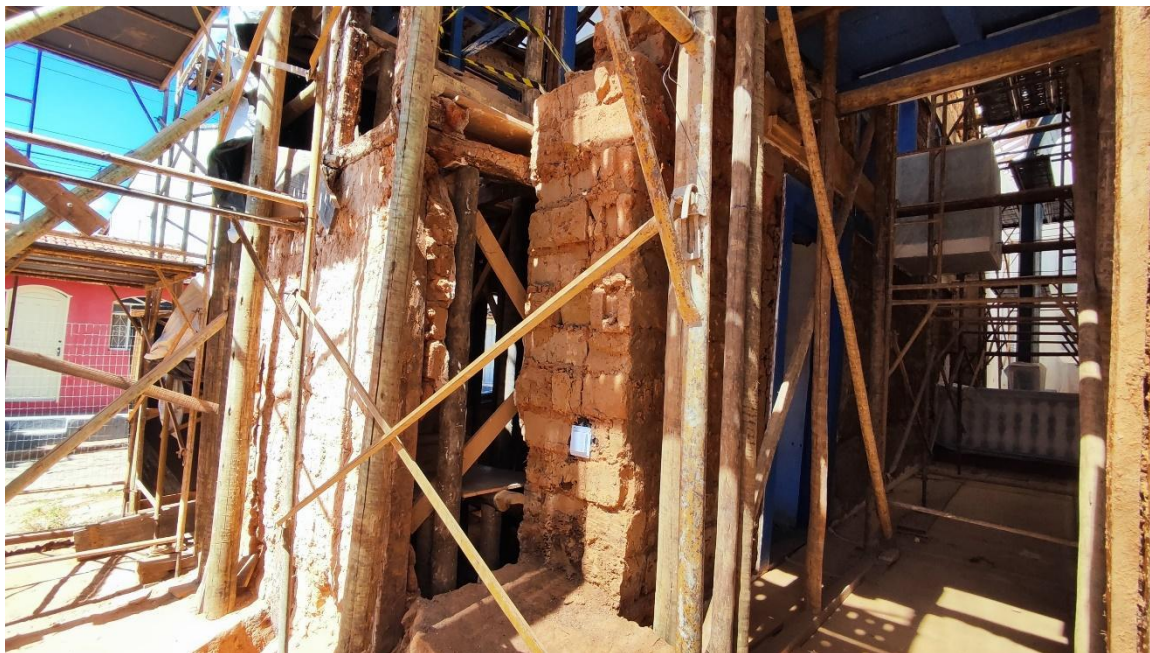
Desmorte da alvenaria da torre Autoria: Francielle Ferreira Data: 06/08/2024
