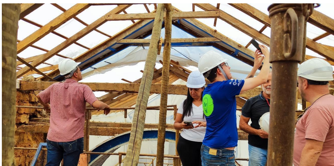
Análise dos serviços sendo executados na cobertura da edificação Autoria: Francielle Ferreira Data: 06/08/2024
