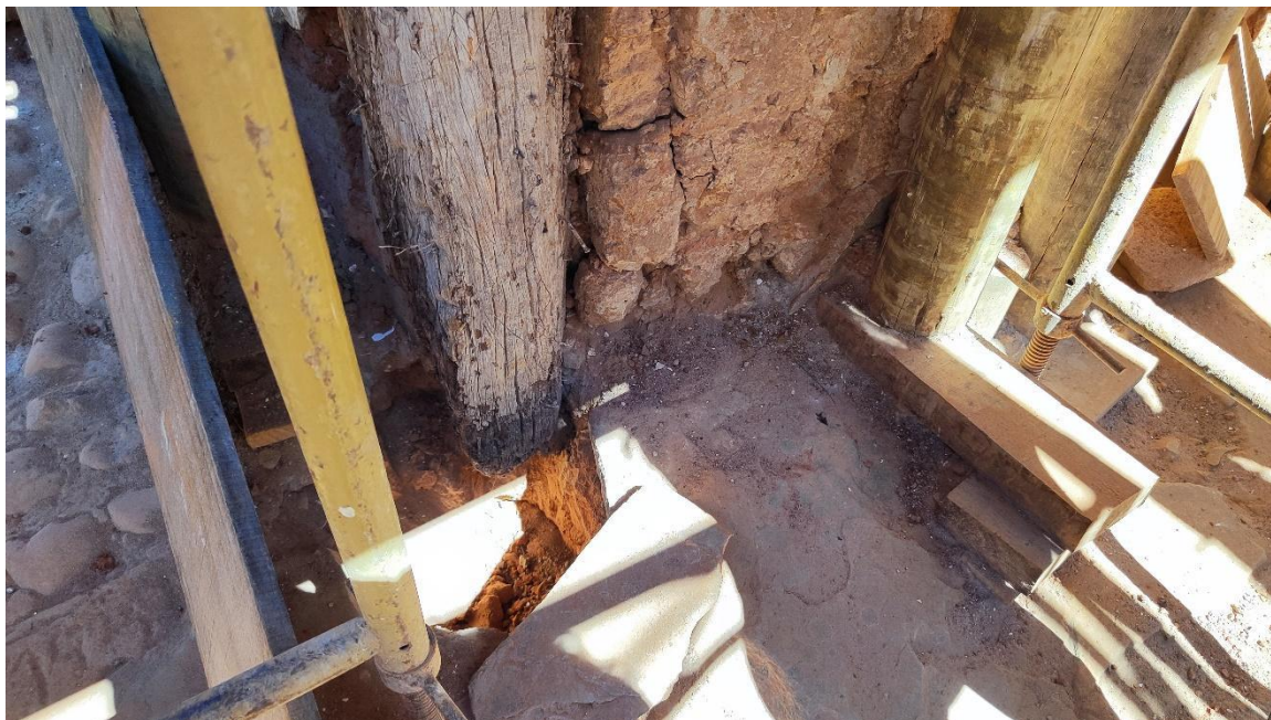
Abertura de vala para execução de reforço estrutural da torre Autoria: Francielle Ferreira Data: 06/08/2024
