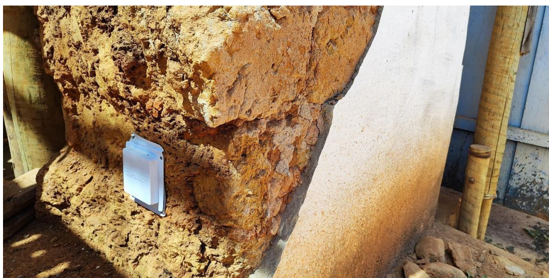
Abertura de vala para execução de reforço estrutural da torre Autoria: Francielle Ferreira Data: 06/08/2024
