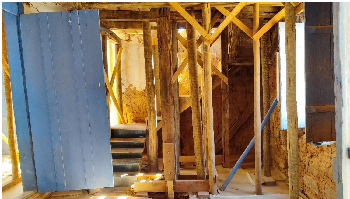
Escoramento da estrutura do piso das tribunas, localizadas sobre a sacristia. Autoria: Francielle Ferreira Data: 06/08/2024
