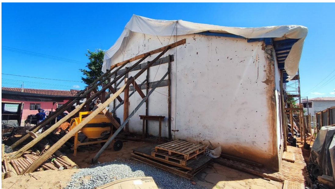
Escoramento das fachadas e início da execução dos serviços na cobertura da sacristia Autoria: Francielle Ferreira Data: 06/08/2024
