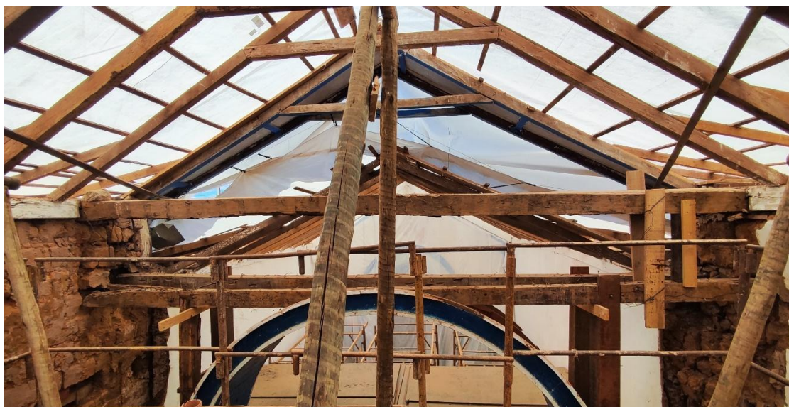
Remoção do entelhamento e execução de reparos estruturais no engradamento Autoria: Francielle Ferreira Data: 06/08/2024
